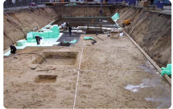
Ringerter bei Perimeterdämmung
