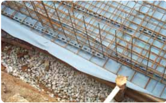
Folie bei Fundamentplatten
