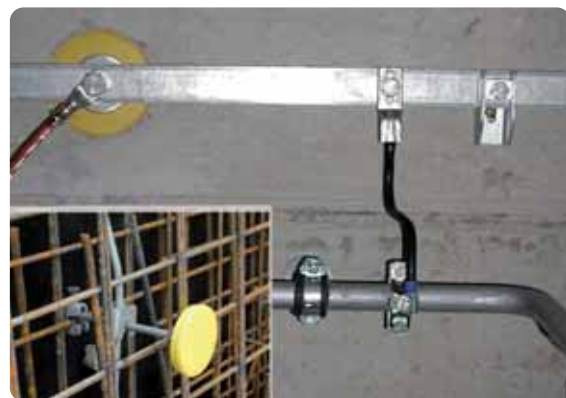
Anwendung Erdungsfestpunkt
