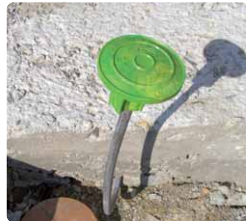
Schutzkappe auf Anschlussfahne
