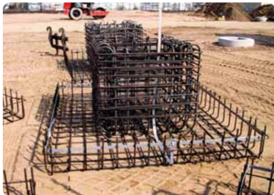
Fundamenterder bei Einzelfundamenten mit Anschlussfahne
