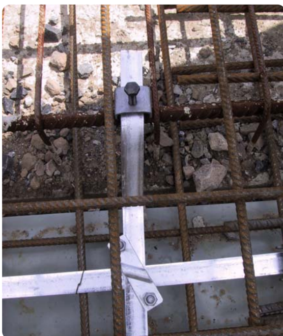
Anwendung Verbindungsklemme und SV-Klemme
