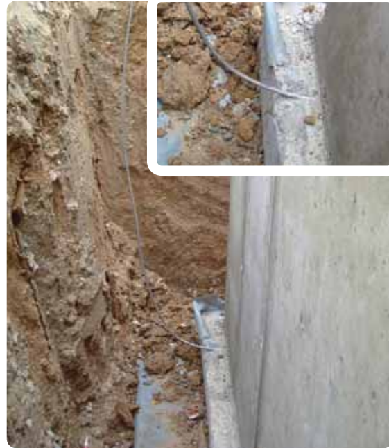
Korrosionsfreie Anschlussfahne aus NIRO (V4A)
