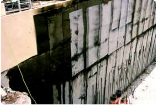
Bitumenbahnen als Abdichtung
